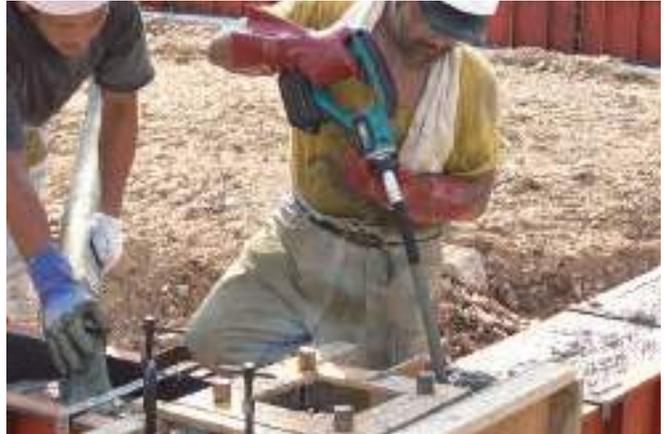
**VR002C VIBRADOR DE CONCRETO INALÁMBRICO**
